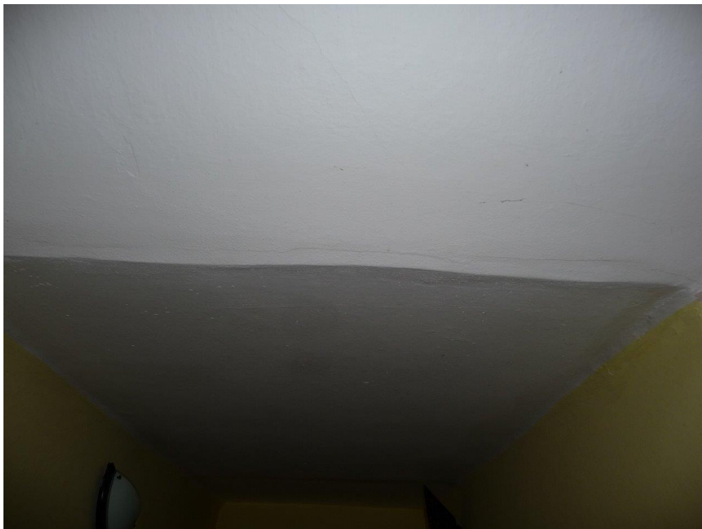
Foto č. 37 – Chodba – drobné trhlinky ve stropě
